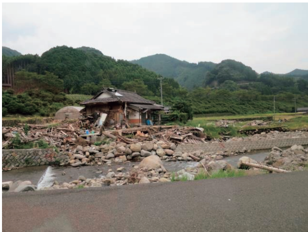
平成 29 年 7 月九州北部豪雨 被害状況
